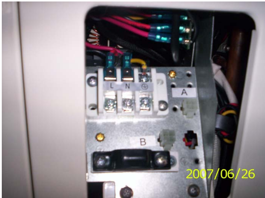
2. ábra: A kültéri egység sorkapocs elrendezése
